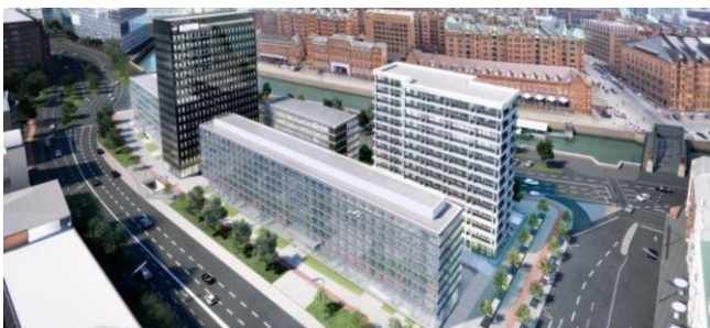
ADINA Hotel Speicherstadt Hamburg
